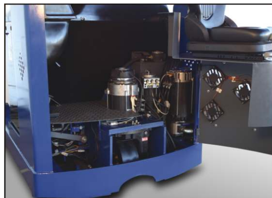
Transmissão ZF, bomba hidráulica Bosch e motores Sauer Danfoss (direção, elevação e tração).
